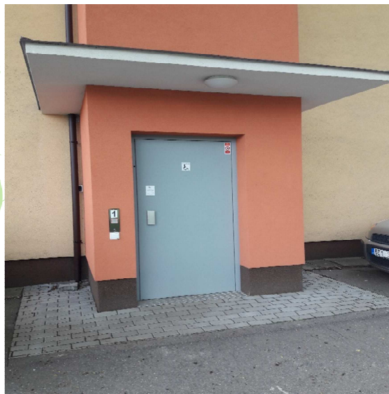
Plošina – z boku budovy
