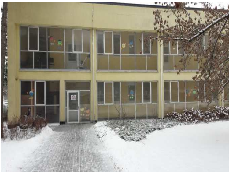
Budova Integrovaní školky (1.NP) a Rehabilitačního centra (2.NP)
