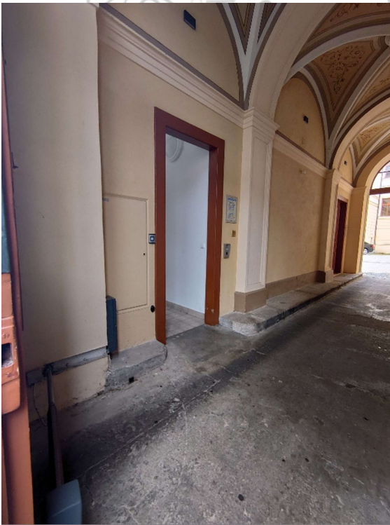
Vstup do traktu B – přístup k výtahu (z průjezdu)
