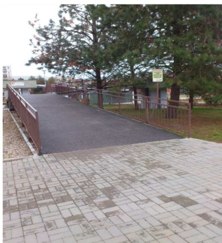
Přístup po rampě do 2.NP budovy
