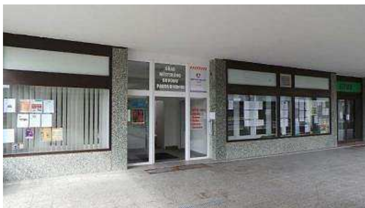
Městská policie Obvod 3 – vstup ve 2.NP
