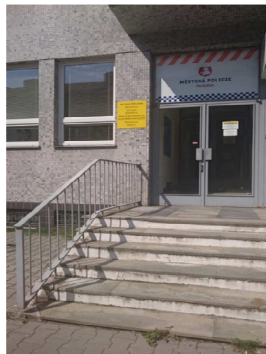
Hlavní vstup do budovy
