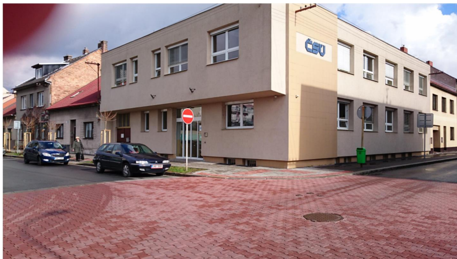
Vstup do budovy
