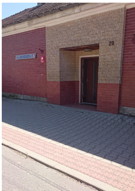
Vstup do budovy
