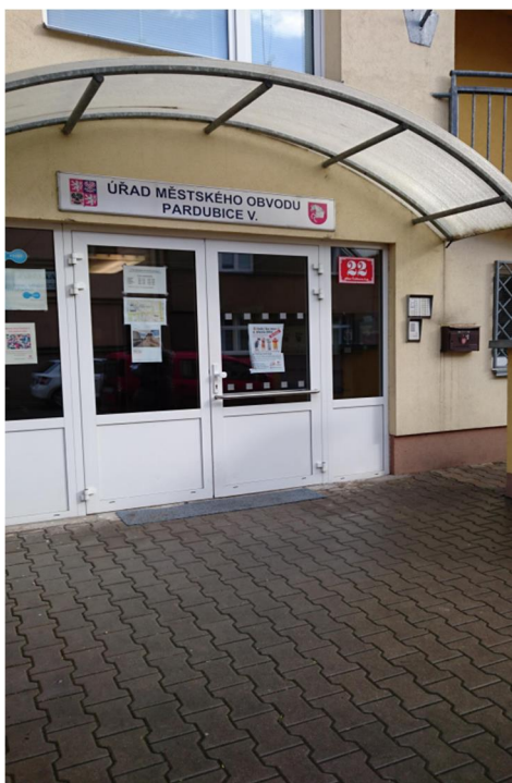
Vstup do budovy
