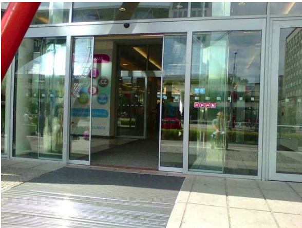
Vstup od ulice Palackého
