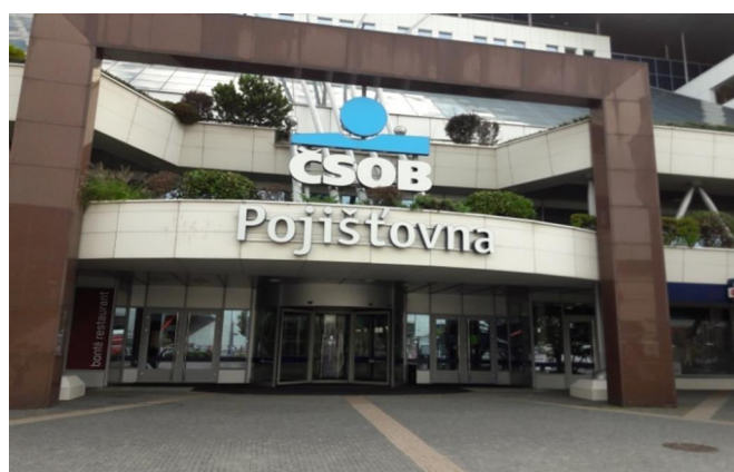
Hlavní vstup do budovy (Masarykovo nám. 1458) ó Restaurace v 1. NP
