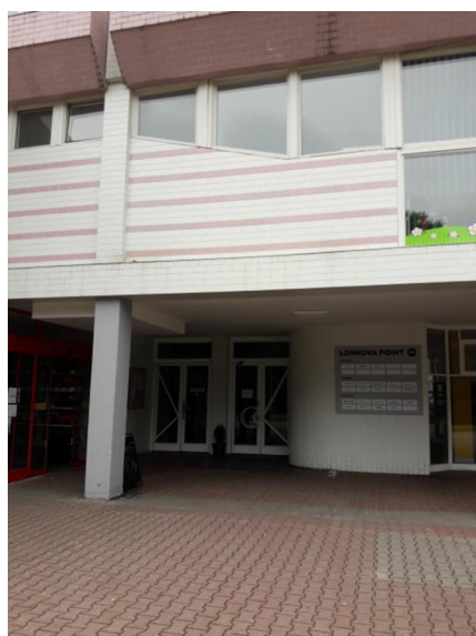
Vstup do budovy
