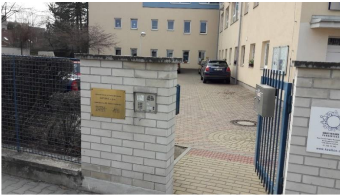
Vstup do areálu školy
