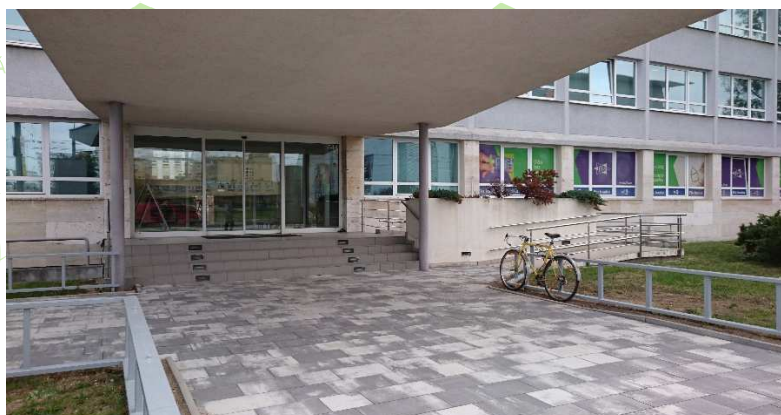
Vstup do budovy – vpravo rampa
