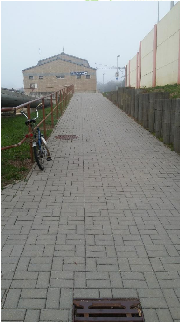
Přístup k budově – nástupiště směr Přelouč
