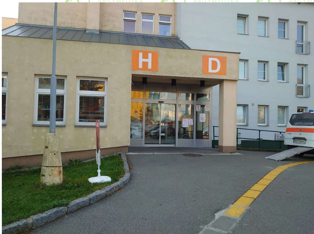
hlavní vstup do budovy H
