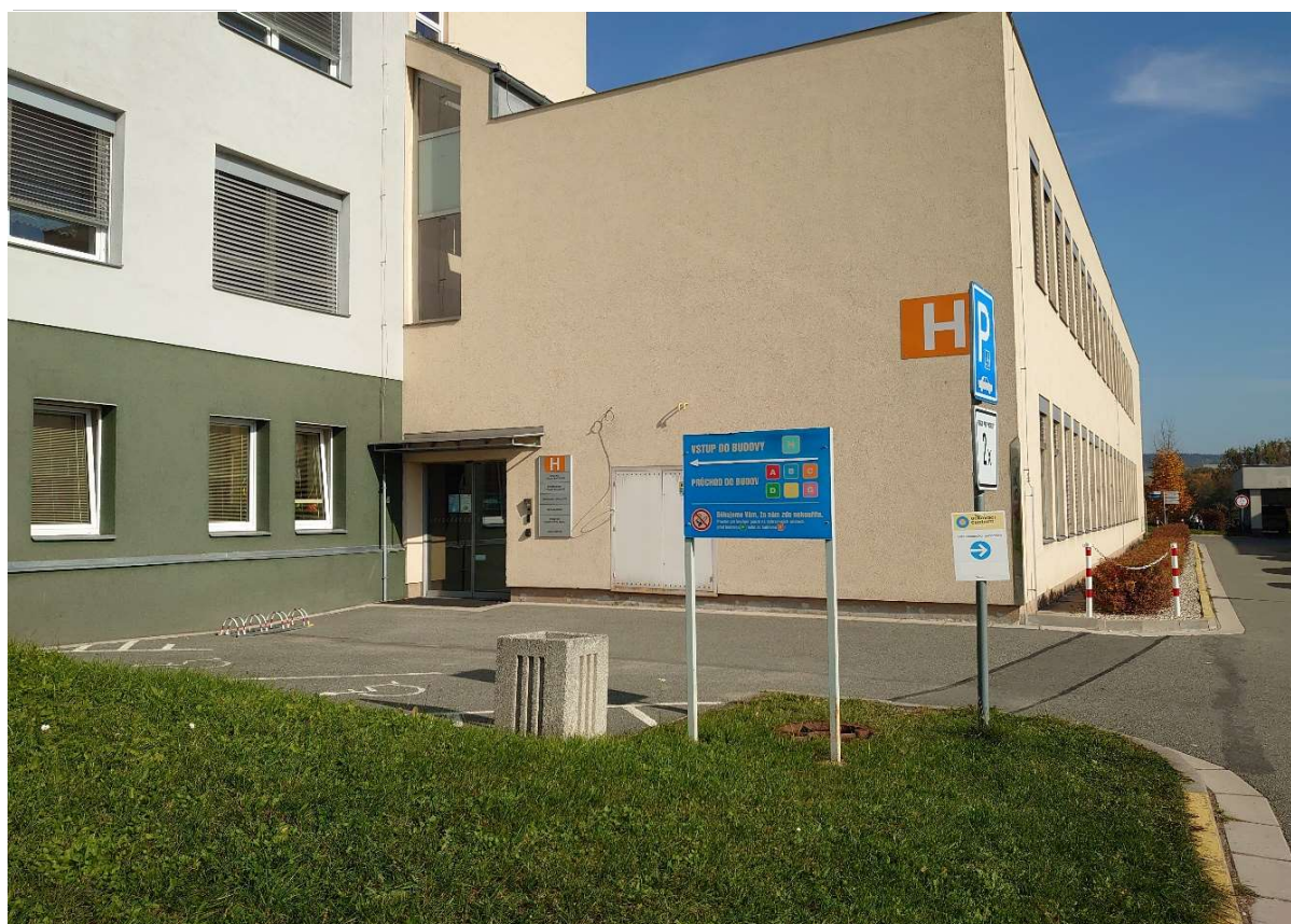
zadní vstup do budovy H
