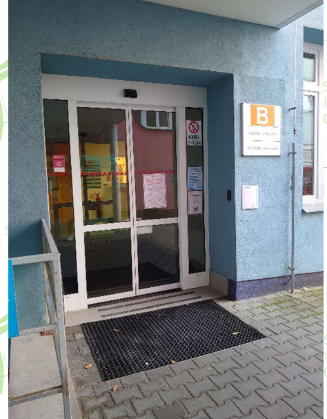
vedlejší vstup (ze zadu budovy)
