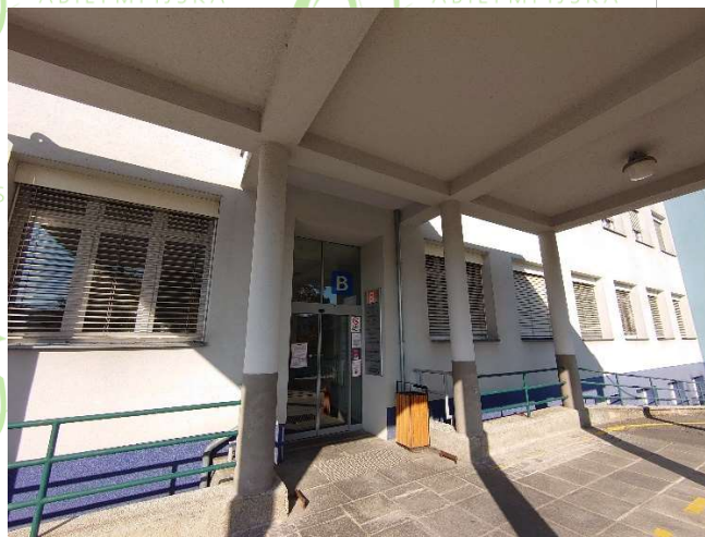
hlavní vstup do budovy B
