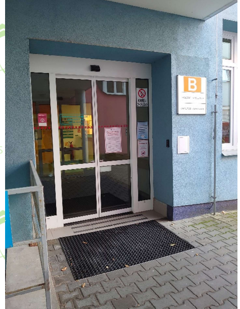
vedlejší vstup (ze zadu budovy)
