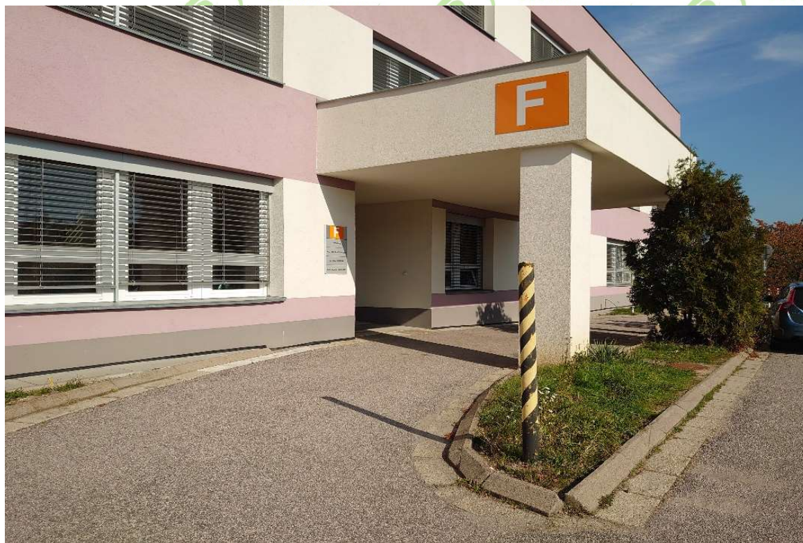
vstup do budovy F
