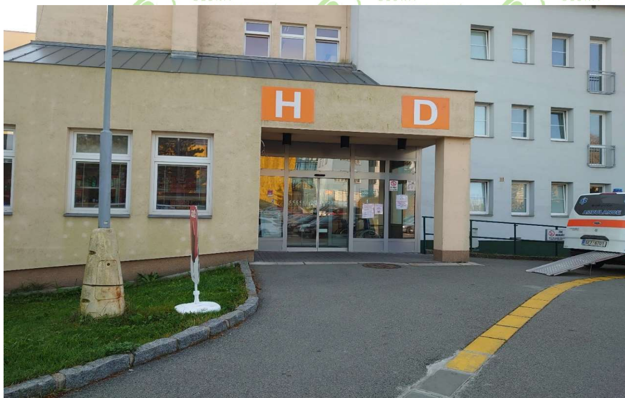
vstup do budovy H a D
