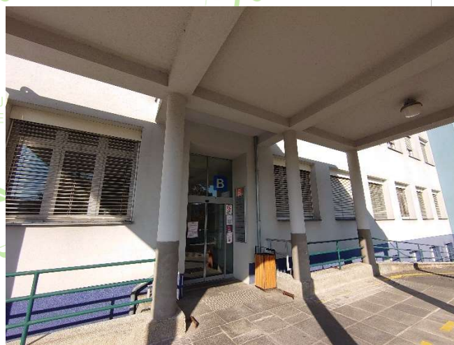
hlavní vstup do budovy B
