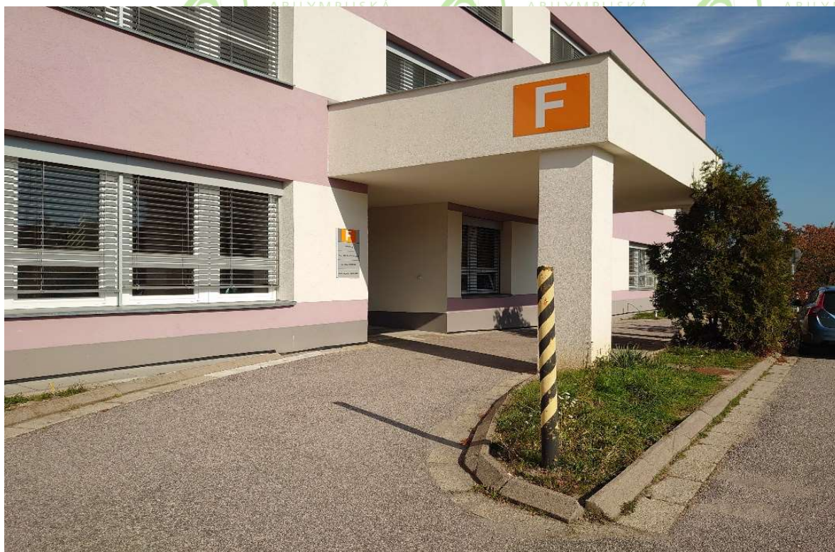
vstup do budovy F
