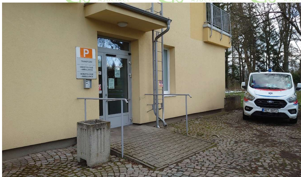
vstup do budovy P
