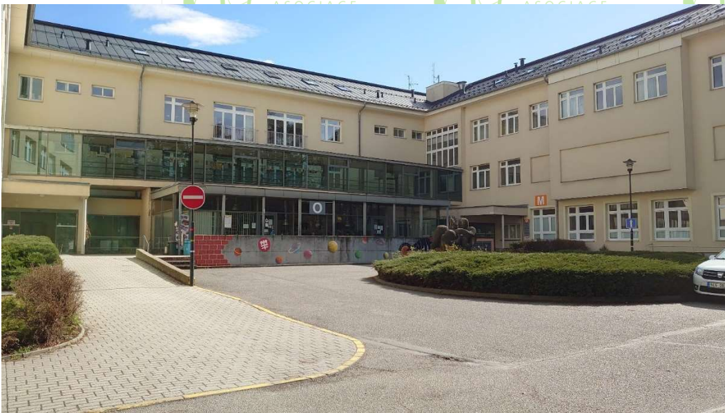
Monoblok - budova M (přístup vlevo)
